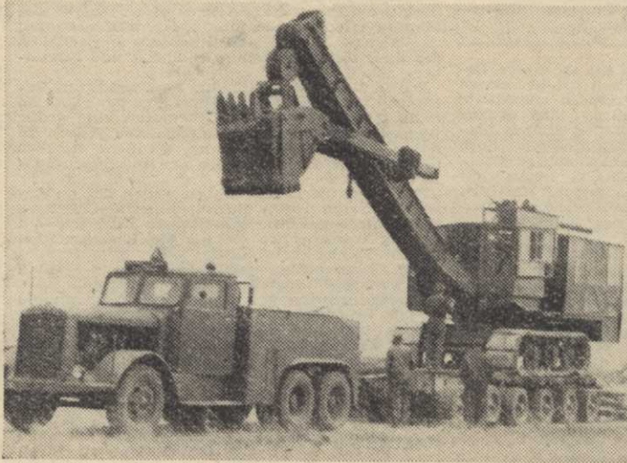
Groß ist die Unterstützung, die der Sport durch unsere Regierung erhält. Zum Stadionbau in Meerane wurde dieser riesige 52-Tonnen-Bagger der Schwerlast-Brigade Ernst Thälmann zur Verfügung gestellt. Es wird also auch hier alles getan, um den geplanten Stadionbau zu vollenden. Meerane wird die so lange entbehrte Großanlage bald bekommen. Foto: Winkler
