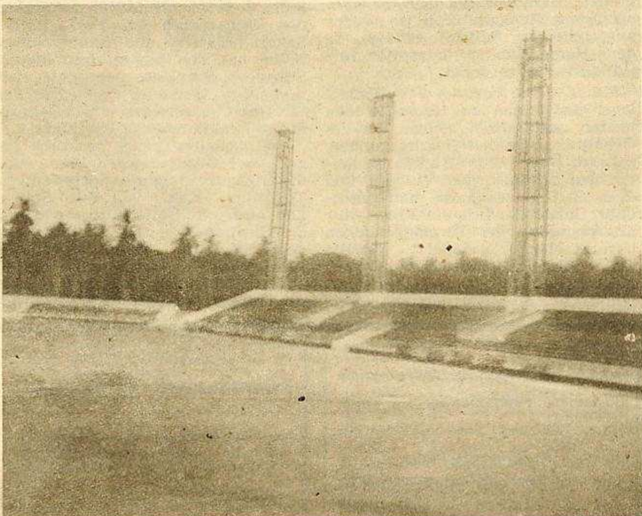
Blick auf einen Teil des repräsentativen Amani-Stadions in Sansibar, ausgestattet mit einem Rasenfeld und einer Tartan-Kunststoffbahn. Es faßt 25 000 Zuschauer.
