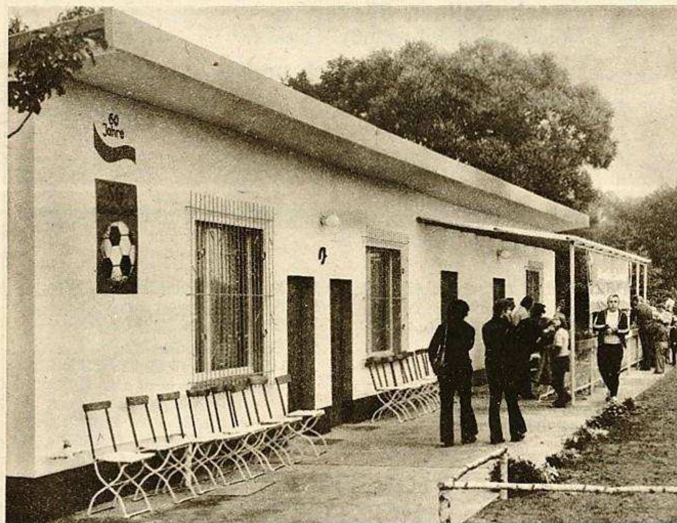
Das selbsterbaute Mehrzweckgebäude mit Umkleidekabinen für Mannschaften und Schiedsrichter, Wasch- und Duschaum sowie einem Klubzimmer.
